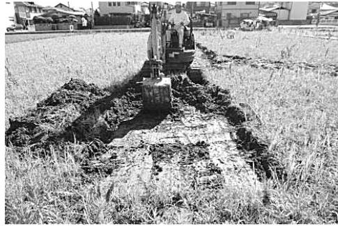
重機による耕作土掘削風景
