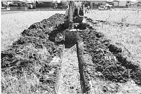
重機によるトレンチ掘削風景
