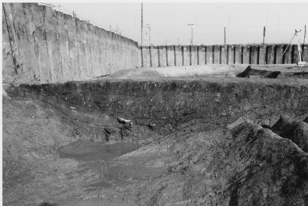
S D01 (2区b-b', 中央畦) 土層断面 南から
