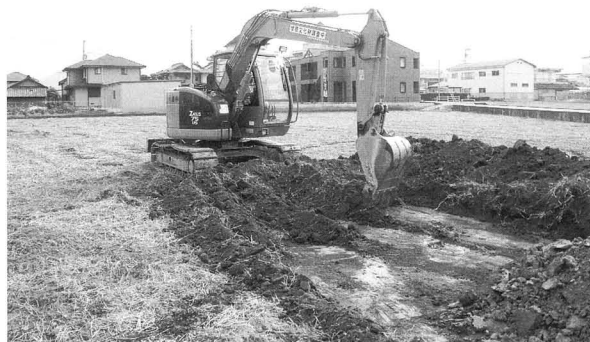
重機による掘削作業風景：西から
