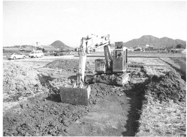
重機による埋め戻し作業風景：西から
