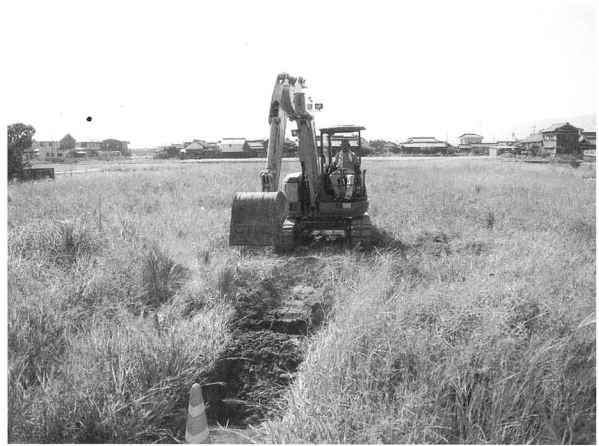
重機による掘削作業風景：北西から
