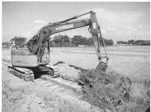
埋め戻し作業風景
