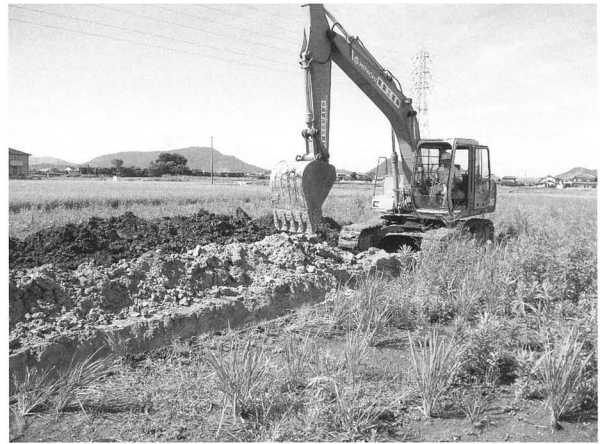
重機による矩掘削作業：東から
