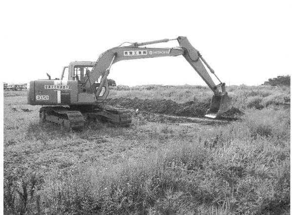
トレンチ埋め戻し作業風景：南東から
