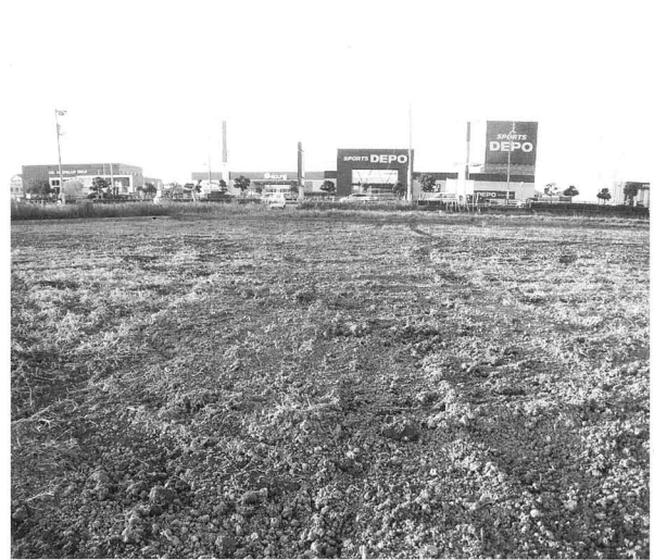
埋め戻し状況：南から
