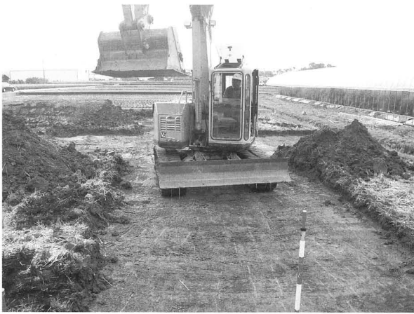
重機による掘削作業風景：北から
