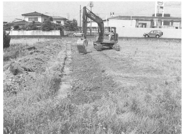
埋め戻し風景：東から
