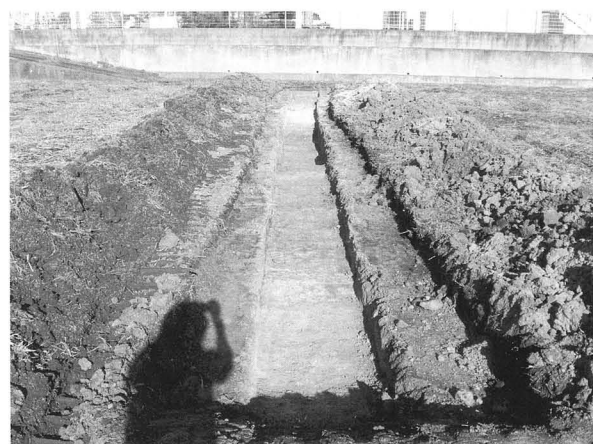
11トレンチ全景：西から
