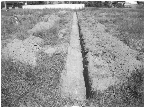
2トレンチ全景：西から
