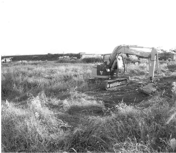
重機による埋め戻し作業風景：東から
