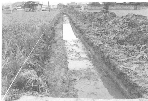
第2図 トレンチ掘削状況
