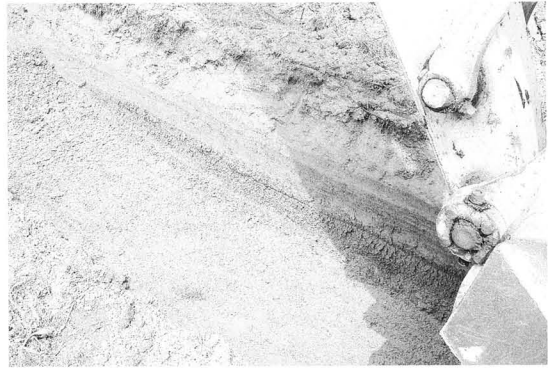
図版2 重機による掘削作業風景
