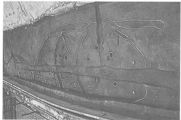
写真55 SH06~10完掘状況（西から）
