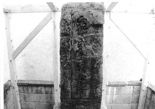
fig.256 含浸後、乾燥中状況
