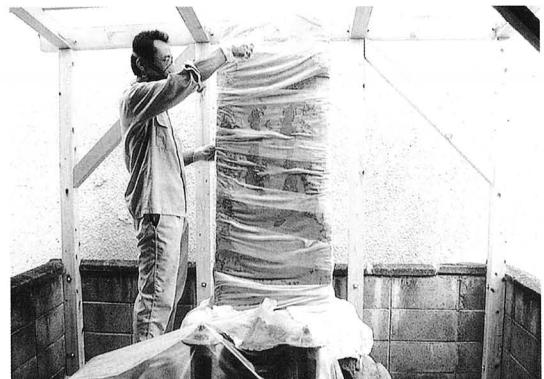
fig.254 接合後、石材強化剤を滴下
