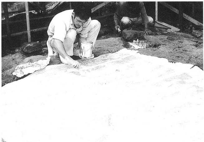
fig.274 エポキシ系合成樹脂塗布作業
