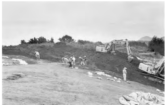
写真2 2次調査の状況（西から）
