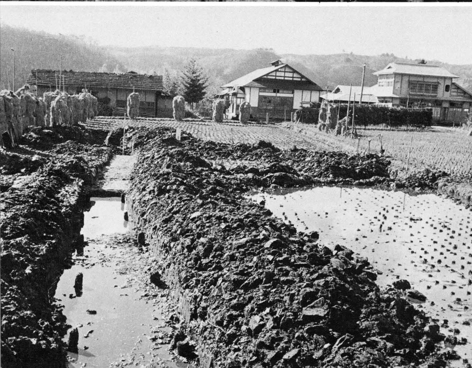
c 北から見た中島跡 と橋柱
