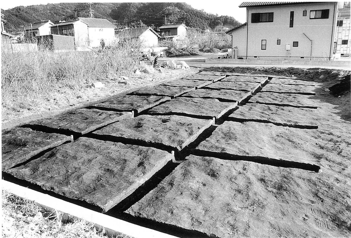
同 上（北西より）
