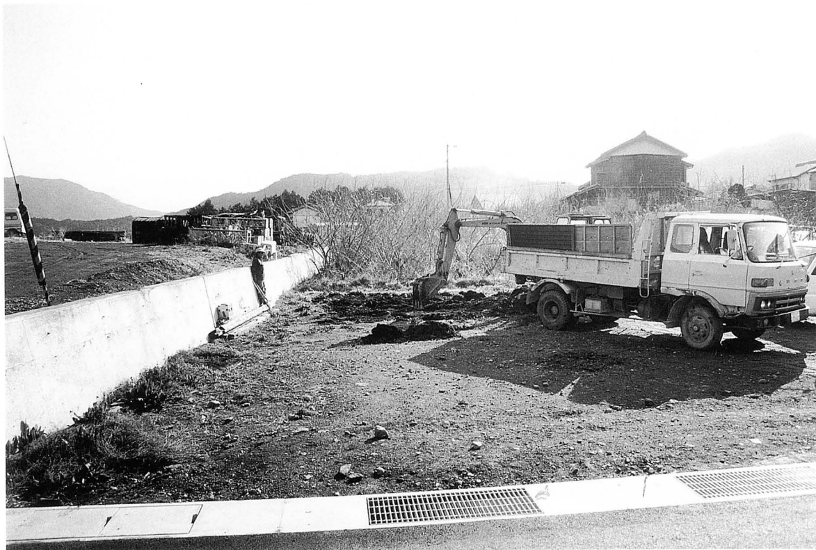
調査状況・表土除去（西より）
