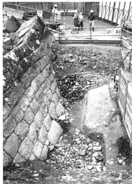
第20図 B面基部 根切り・根石設置状況（東から）
