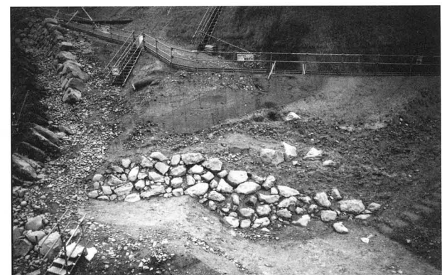
第39図 Ⅰ期石垣を覆うⅡ期盛土状況(北から)
