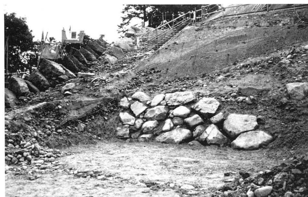
第38図 Ⅰ期石垣を覆うⅡ期盛土状況(北西から)
