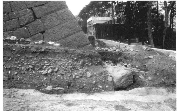
第48図 1区9・10T 西壁断面・Ⅲ期石垣根切り (東から)
