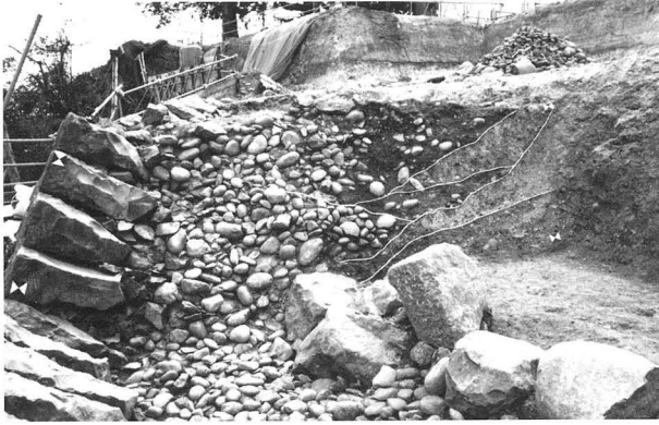
第32図 F面断面の裏込・盛土
