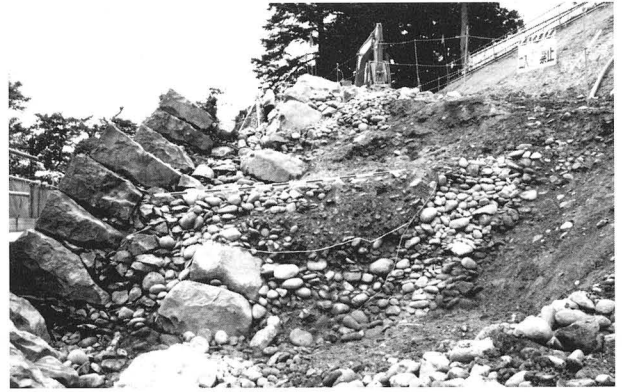
第33図 F面断面のⅡ期・Ⅲ期裏込・盛土
