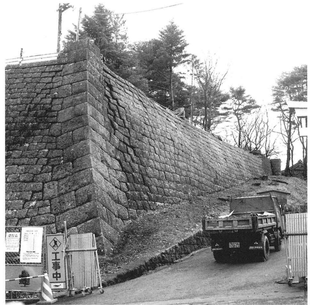
第16図 III期石垣AB角部（解体前・北西から）
