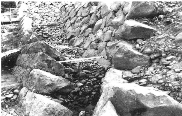
第 13 図 Ⅲ期石垣とⅡ期石垣の裏込め
