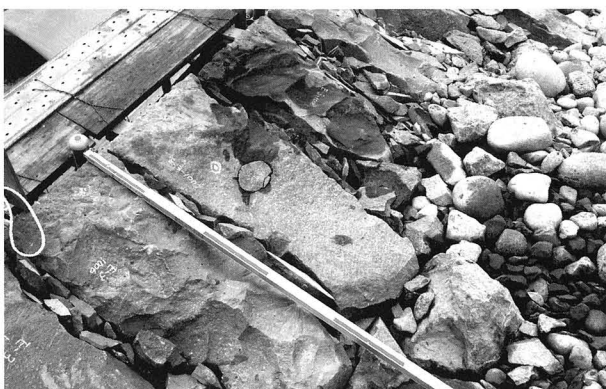
第 451 図 E-03-1003 復旧後 (北西から)
