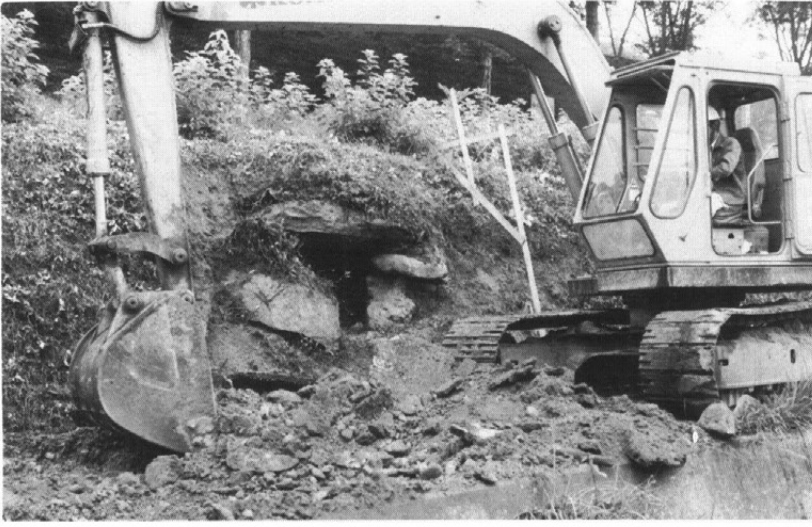
現道舗装除去
