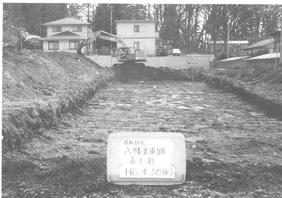
2 バックホーによる 表土剥ぎ (西から)
