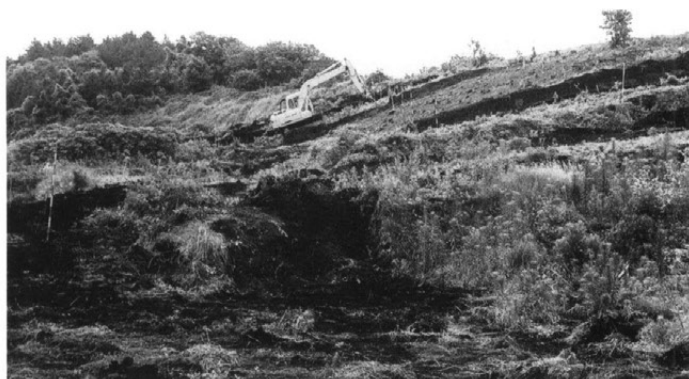
トレンチ掘削
