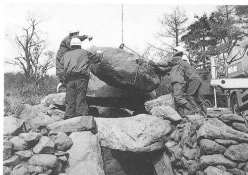
写32 天井石3tの架け直し
