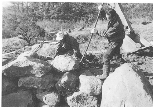
写30 側壁の補強工事（平成9年）
