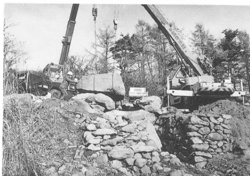
写31 天井石8.2tの架け直し（平成9年）
