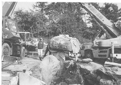
写28 天上石の除去（平成9年）
