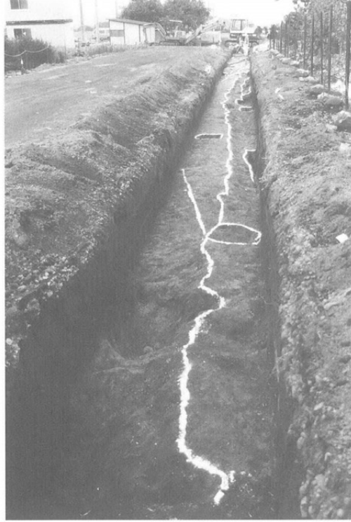
2. 西一本柳遺跡A地区（東方より）
