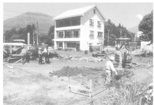
上ノ原遺跡 工事立会
