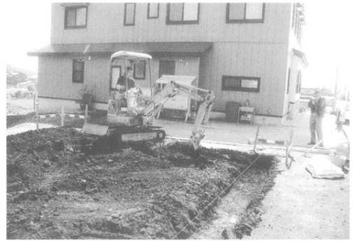
東裏遺跡 工事立会
