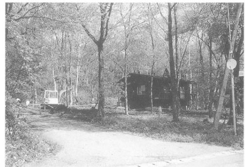
清明台遺跡 工事立会
