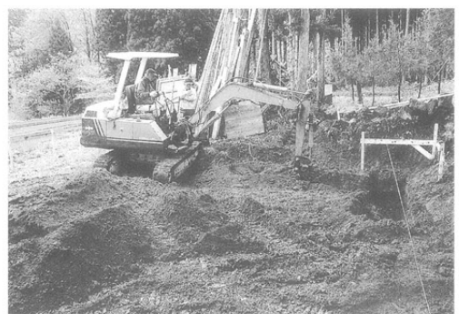
霊仙寺遺跡 工事立会
