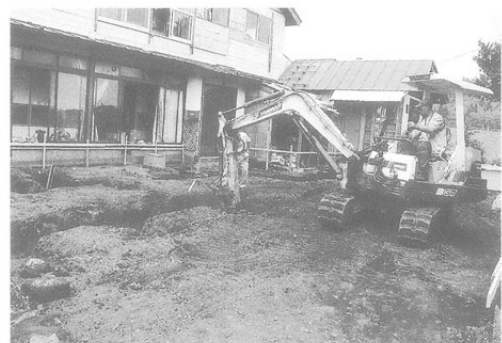
東裏遺跡 工事立会
