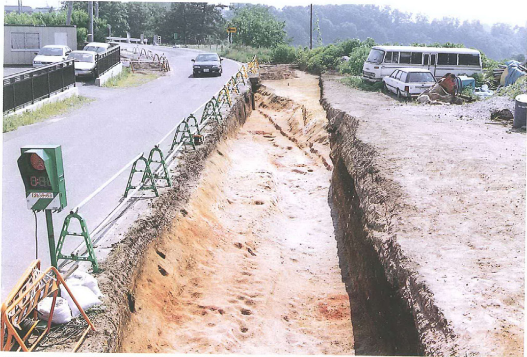
写真1 西大久保遺跡Ⅲ 溝状遺構 B地点 (北より)
