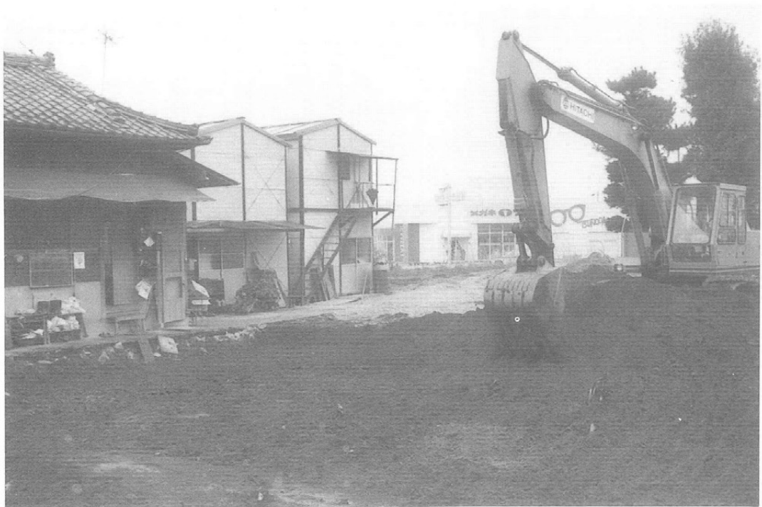
重機作業風景
