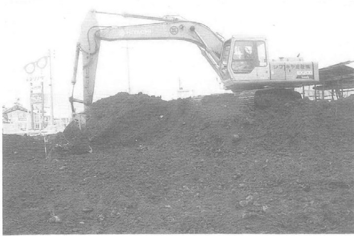
重機作業風景
