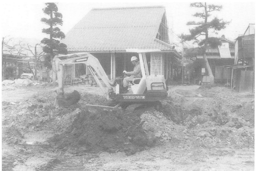
重機作業風景
