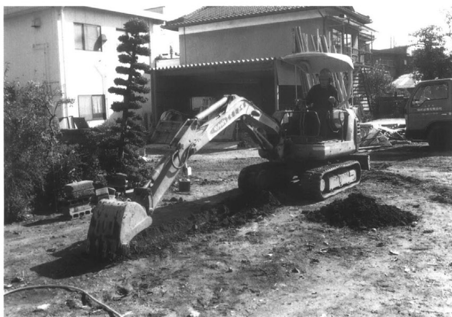
重機による掘削
