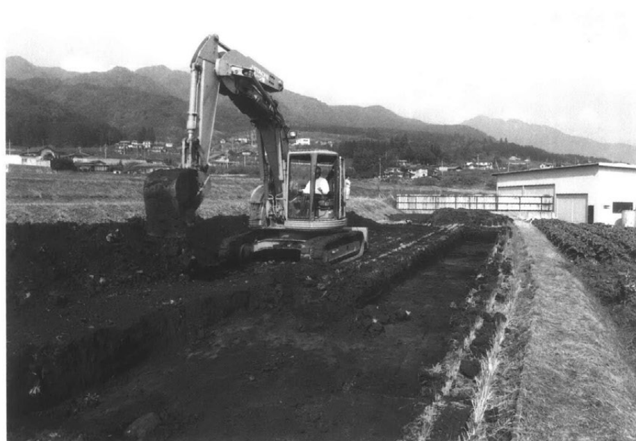
重機による掘削
