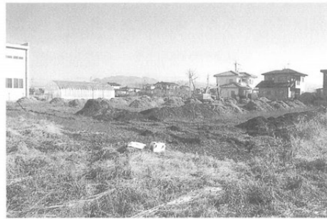
トレンチ掘削状況
