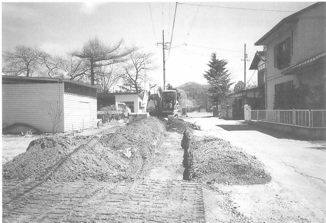
調査状況（西から）
