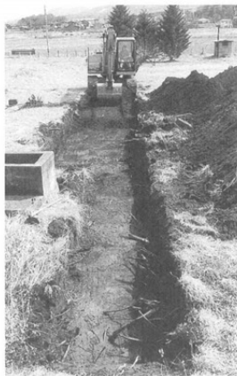
トレンチ掘削状況
