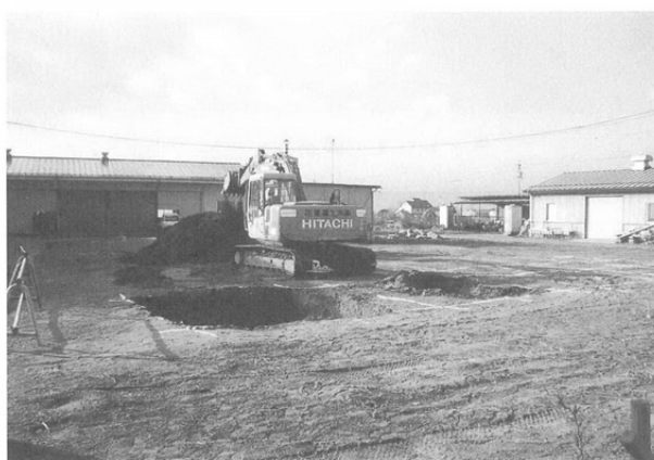
樋村遺跡群1立ち会い状況
