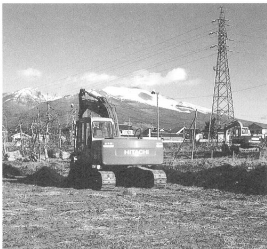
トレンチ掘削状況(南から)
