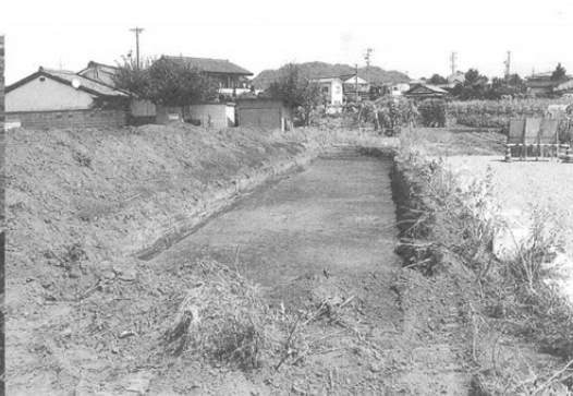
Cトレンチ (西から)
