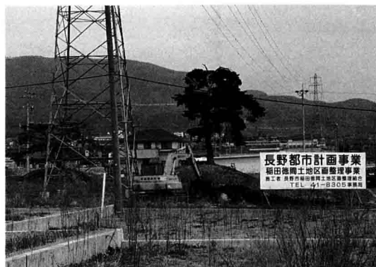
写真3 4月18日重機掘削
