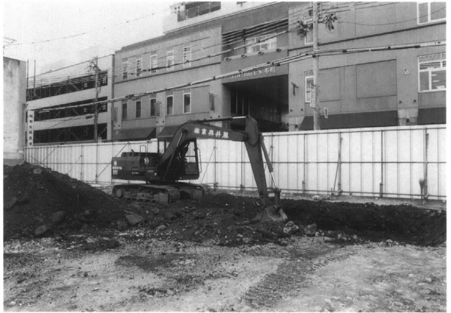
重機による表土剥ぎ
