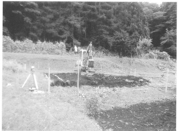
川久保遺跡 工事立会
