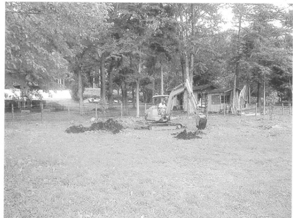
海端遺跡 工事立会
