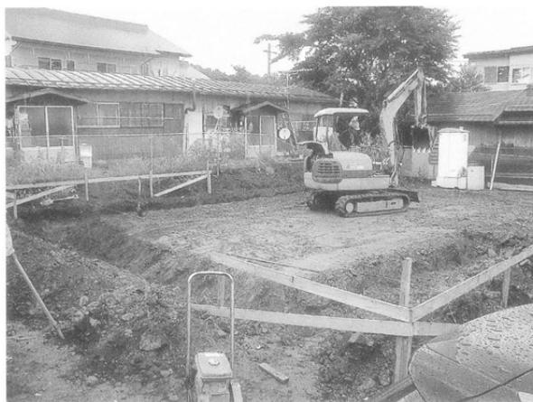
小丸山公園遺跡（No.5） 工事立会
