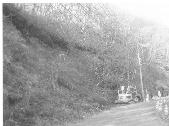
家老路城跡 工事立会
