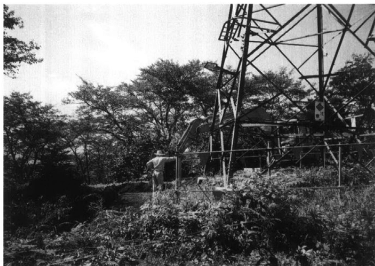
重機作業風景
