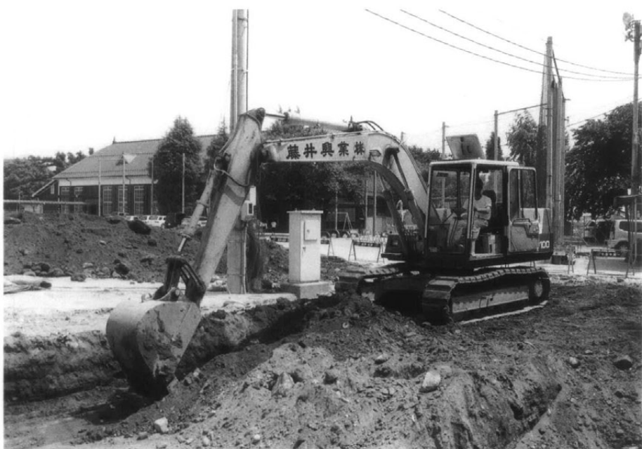
重機作業風景
