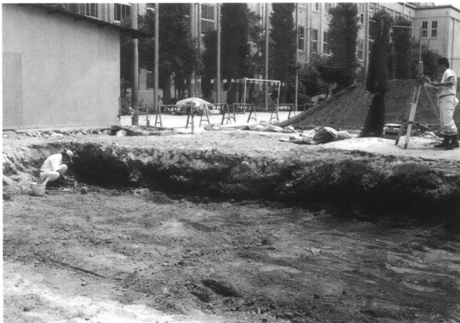
基準点設置作業
