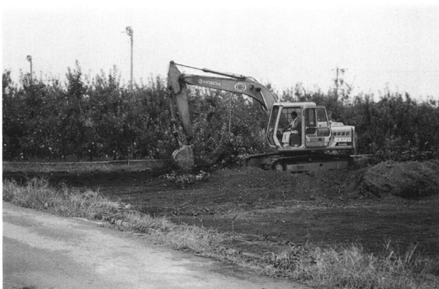
重機作業風景
