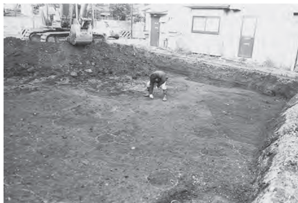
I区表土剥ぎおよび遺構検出作業
