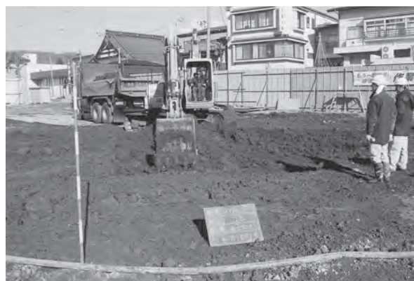
Ⅱ区表土剥ぎ作業風景
