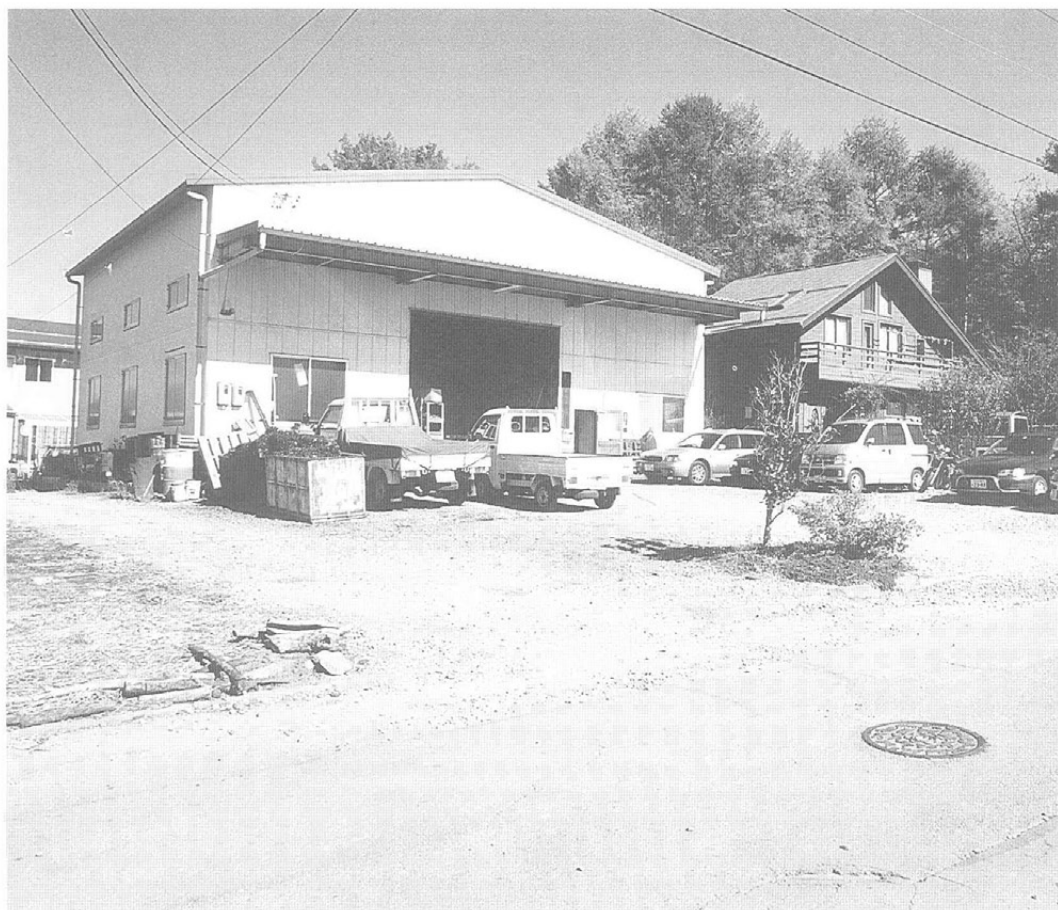
写真1 工場建設予定地
