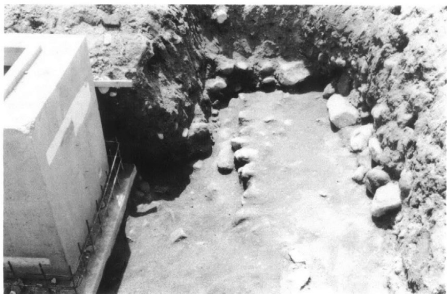
燃焼室 1部配電マンホールで切られる
