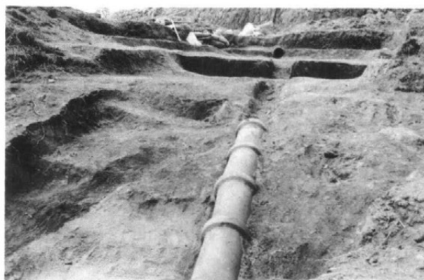
窯址の中央に埋められた排水口管
