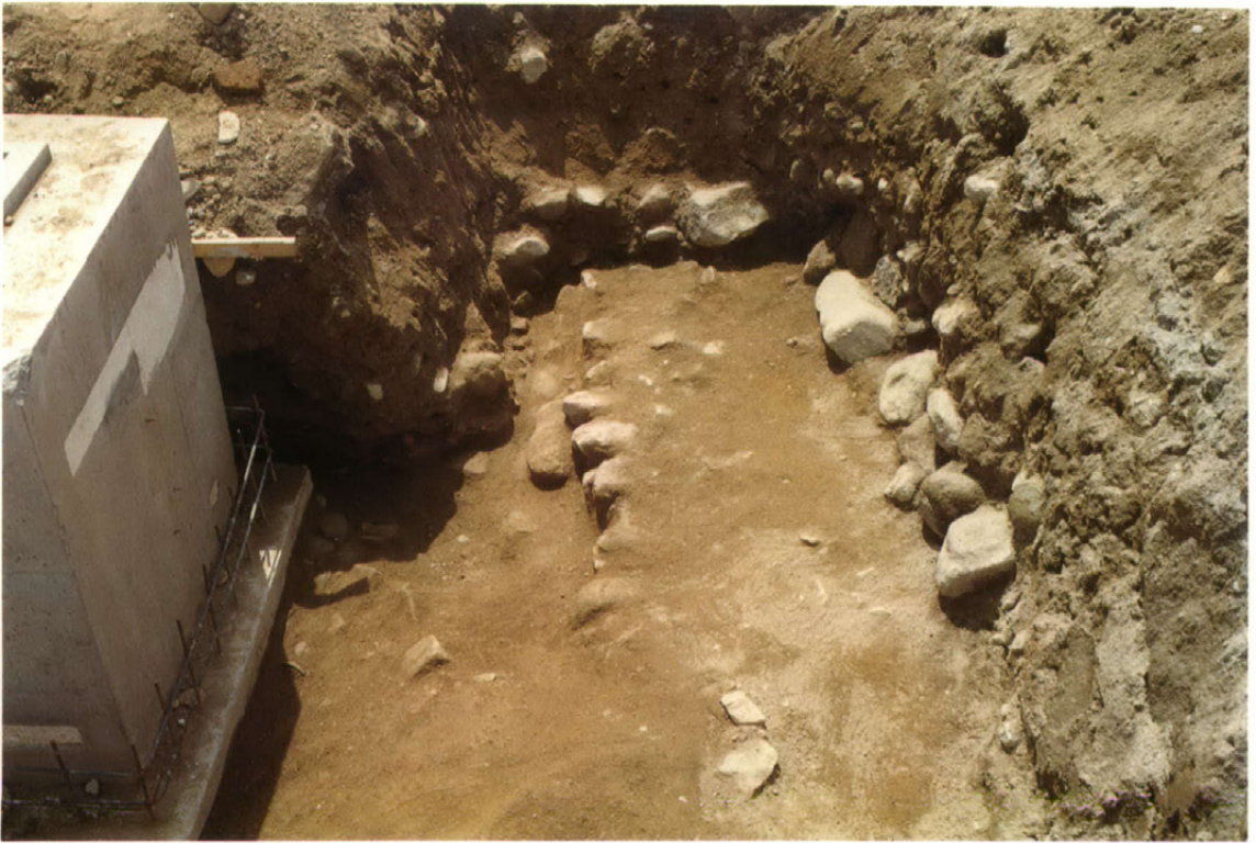
風越 I 号窯燃烧室…配電マンホールのため 2 分の 1 は破壊
