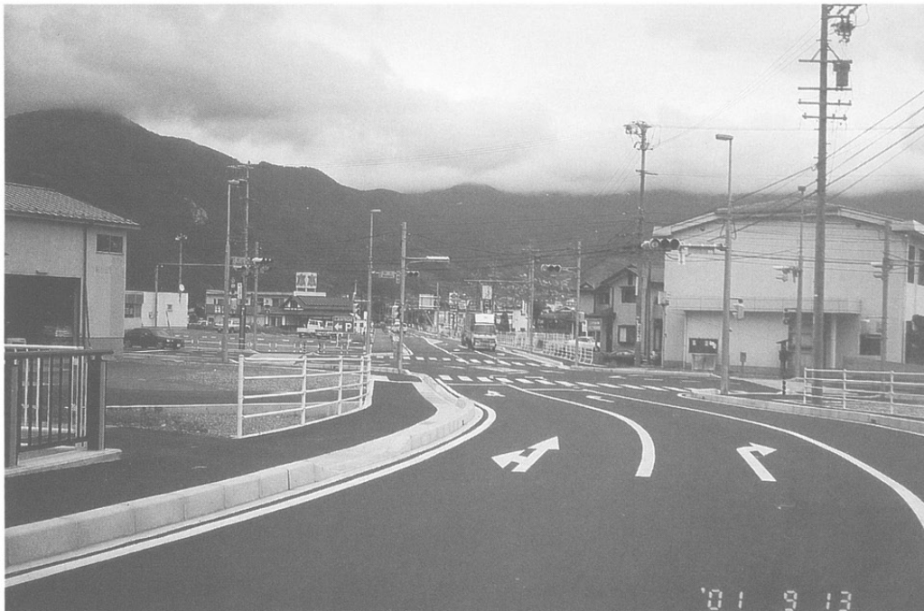
写真4 工事終了後の風景（平成13年9月13日撮影）
