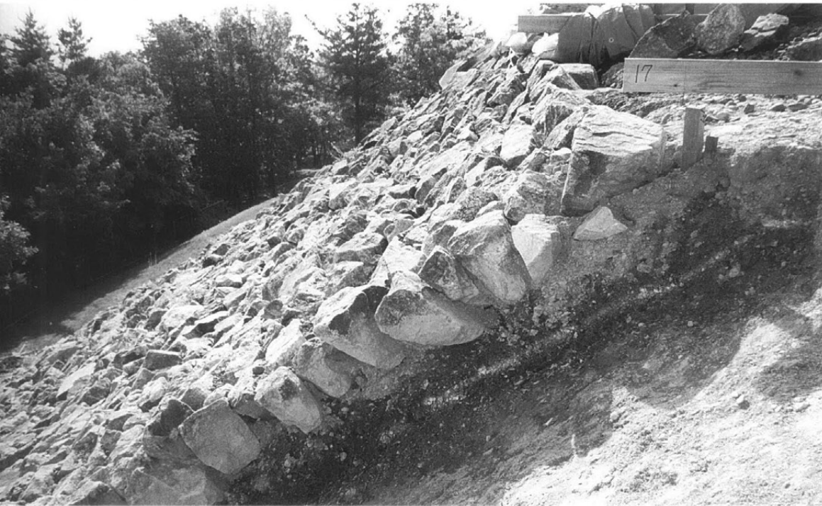
後円部北側丁張りNo.17断面 葺石表面から30cmほどまで の下地土は緩んでいる
