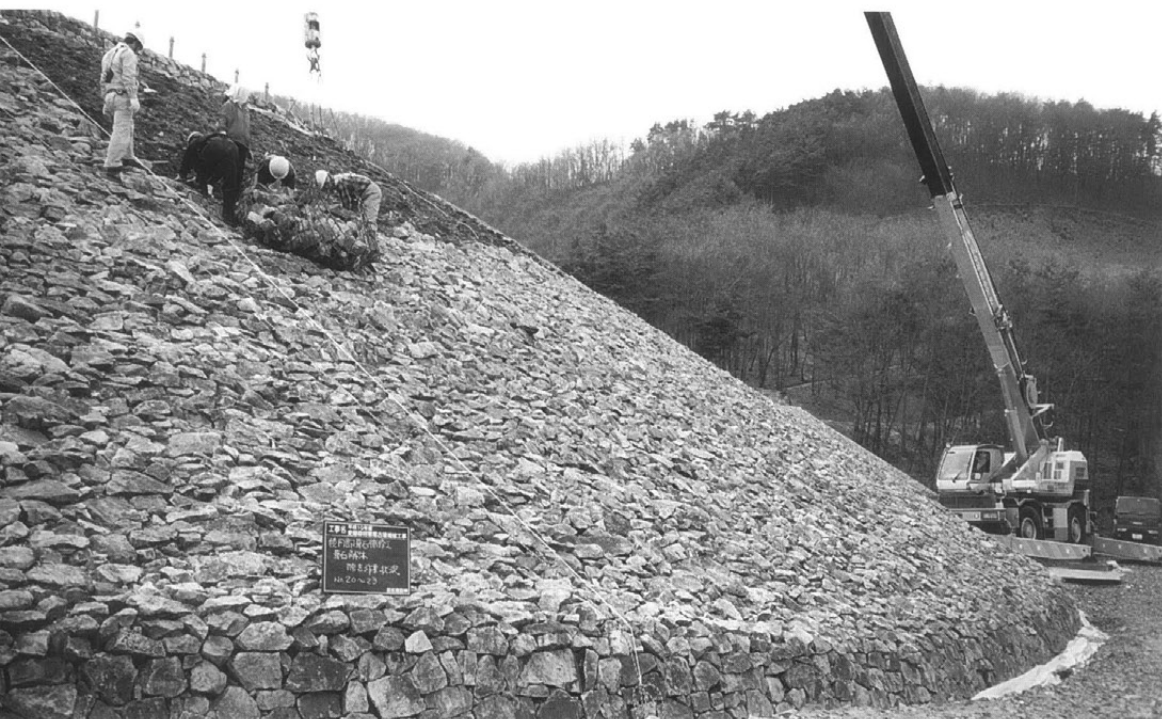
後円部西側 丁張りNo.20～23の間 葺石解体工
