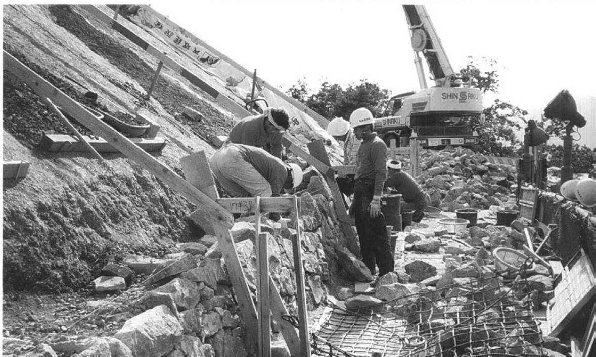
後円部北側 丁張りNo.18付近 裾石垣積み工 変換部に控え力石を設置
