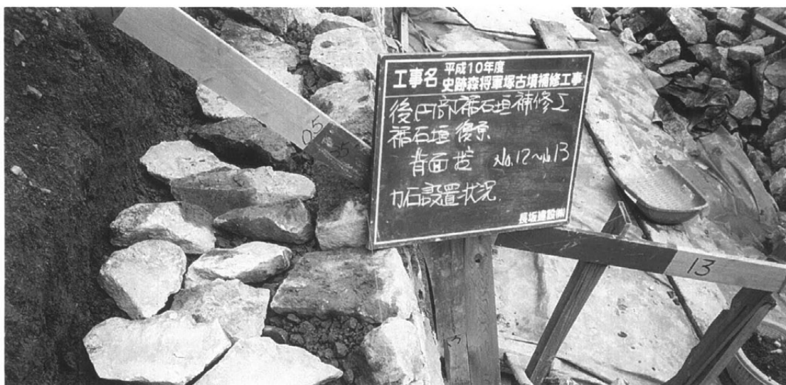
図10 裾石垣復原工
