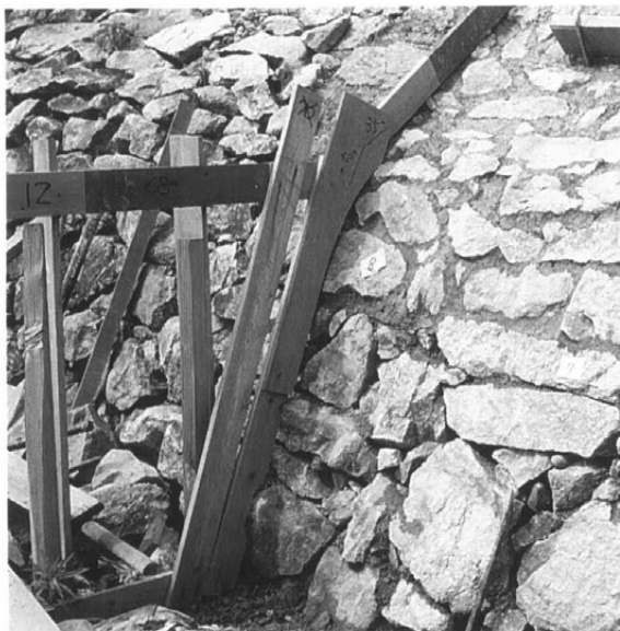
図14 裾石垣変換部の施工
