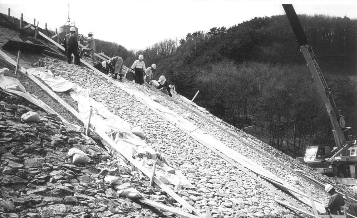
後円部西側 丁張りNo.20～23の間 葺石設置工 5工区に分け順次施工
