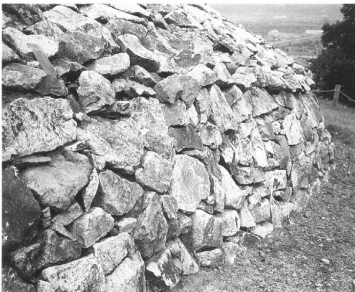
後円部背面 丁張りNo.13～14付近 勾配変換点で連続して石材がせり出している
