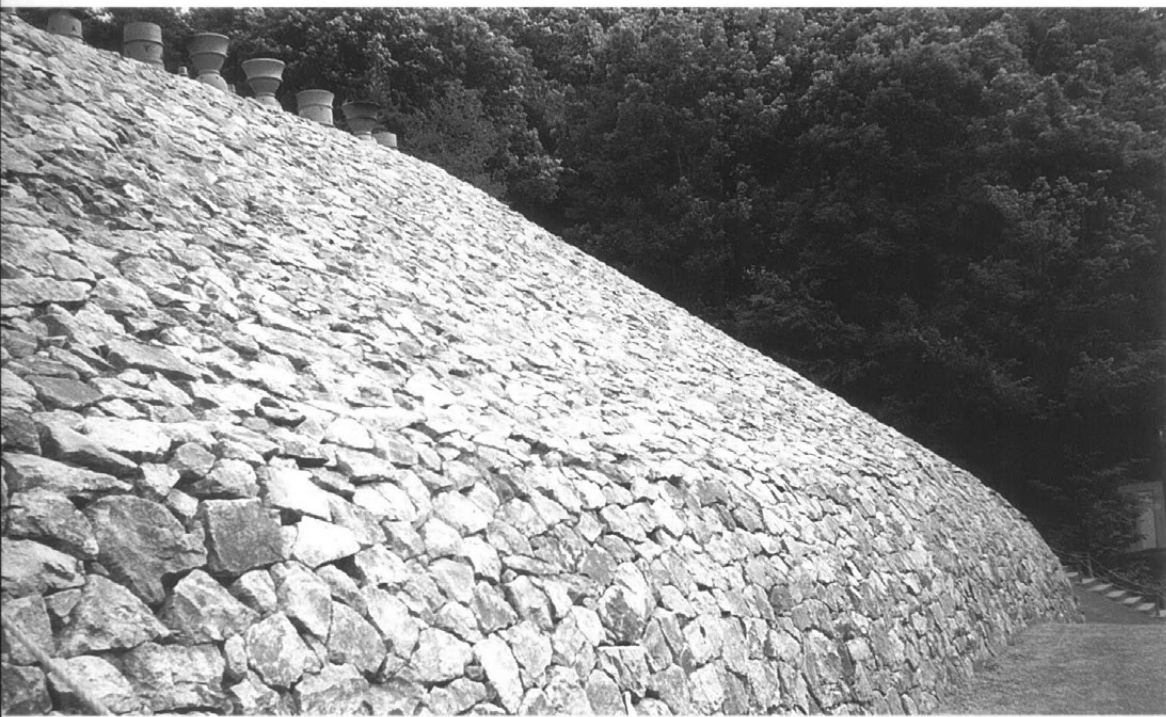
前方部西側 変換点の石材がわずかに せり出している
