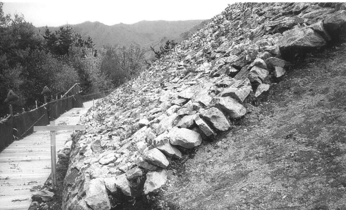
後円部北側丁張りNo.18～19の間 葺石下地土が流失し、墳丘斜面 は凹凸が激しい
