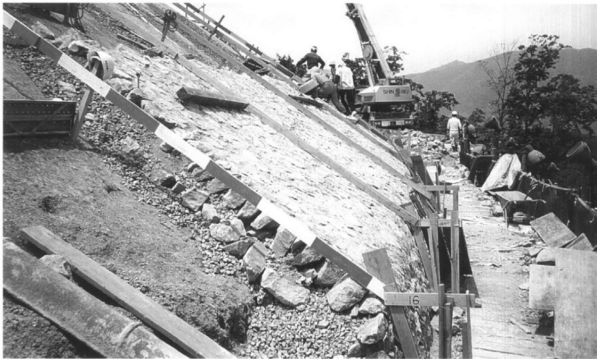
後円部北側 丁張りNo.16付近 葺石下地を碎石に変更
