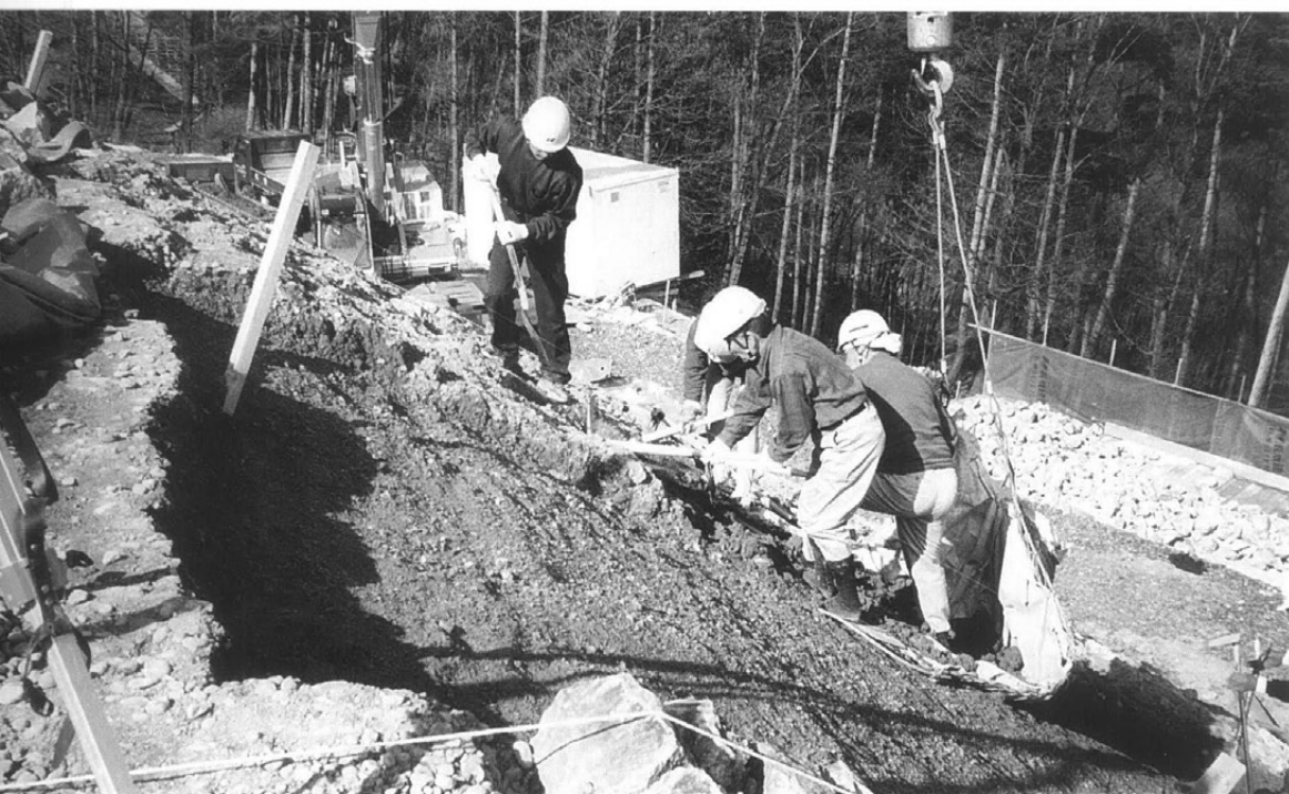
後円部西側 丁張りNo.20～23の間 葺石下地土解体工
