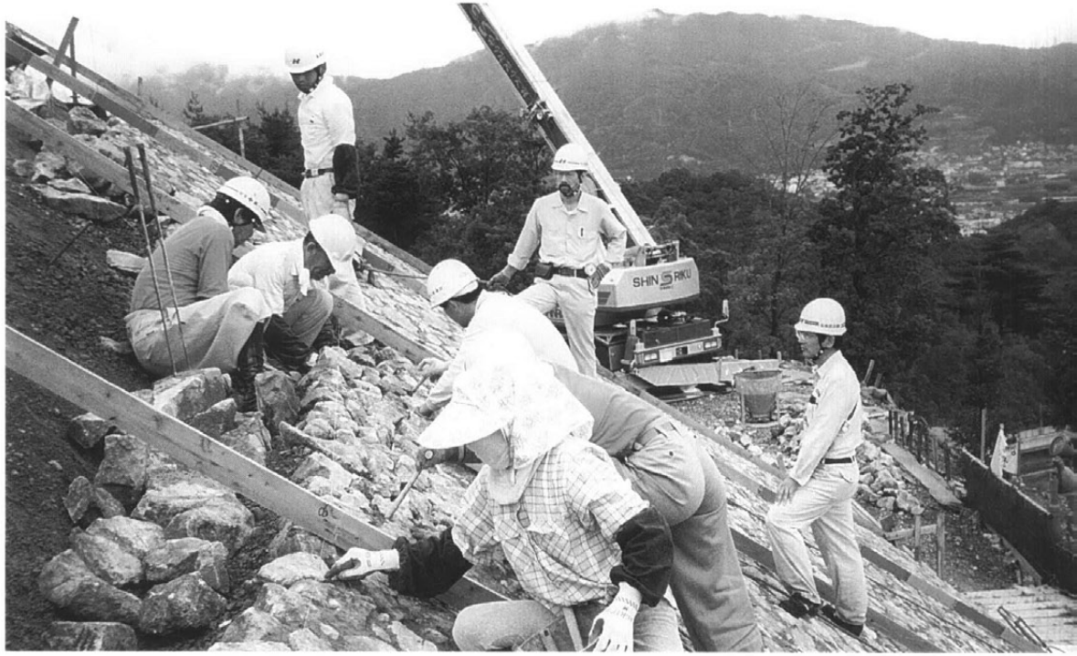
後円部北側 丁張りNo.17~18の間 葺石設置、目地詰め工
