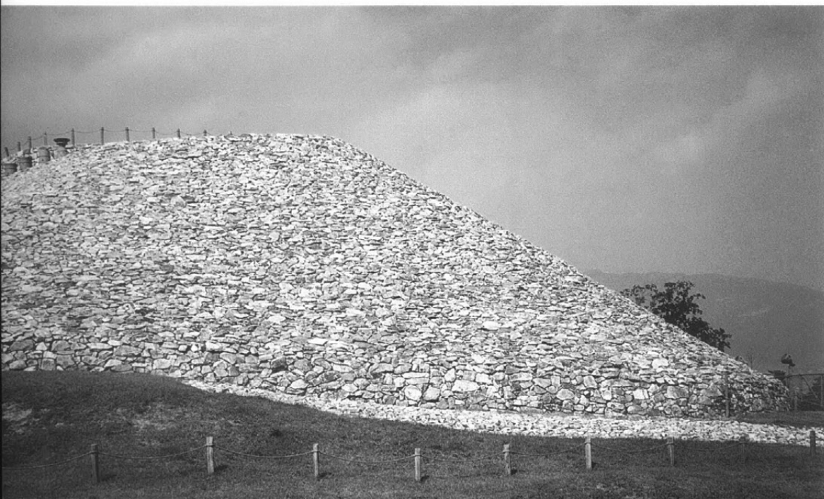
後円部背面 変換点の石材がせり出し、 裾石垣上部で崩落が発生
