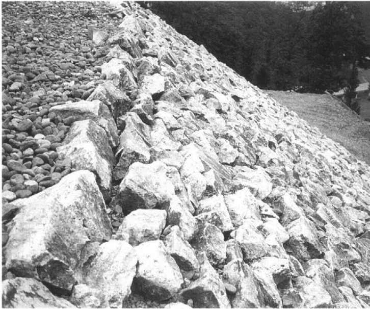
後円部北側上段テラス 丁張りNo.16～17付近 葺石最上部の石材が落ち込み、葺石面が階段状に変動している
