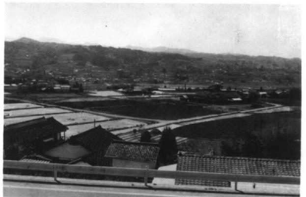
工事終了後の遺跡
