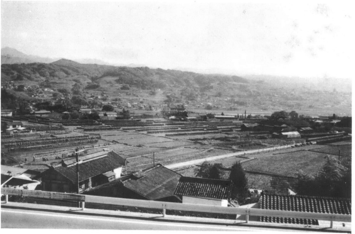
工事前の遺跡
