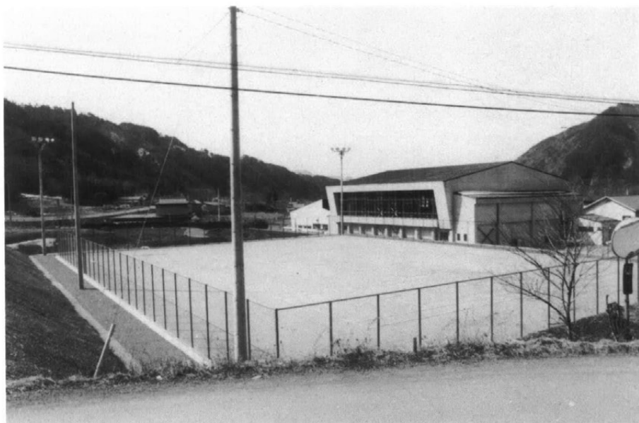
発掘調査後完成した村営庭球場
