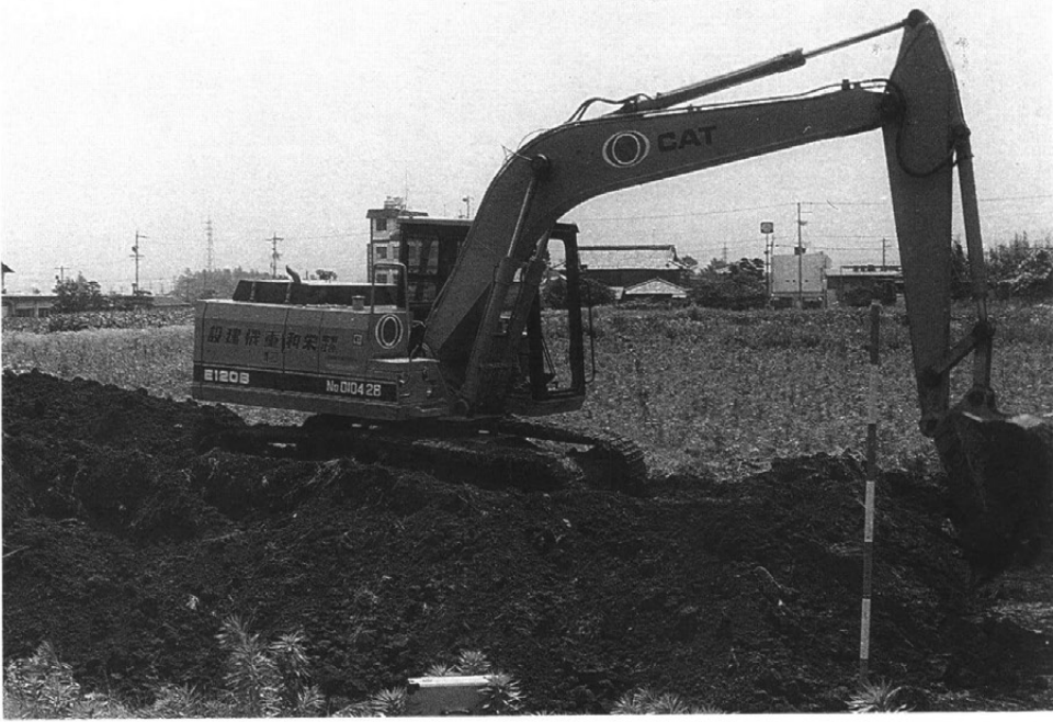
重機作業風景
