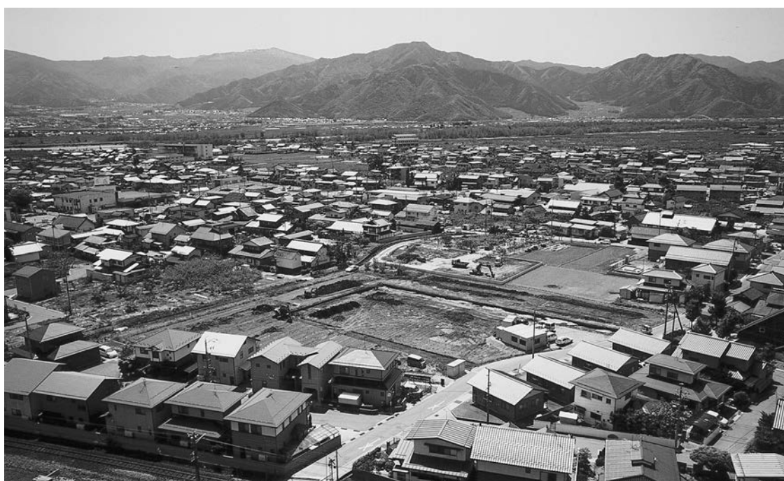
調査地遠景（北西から）
