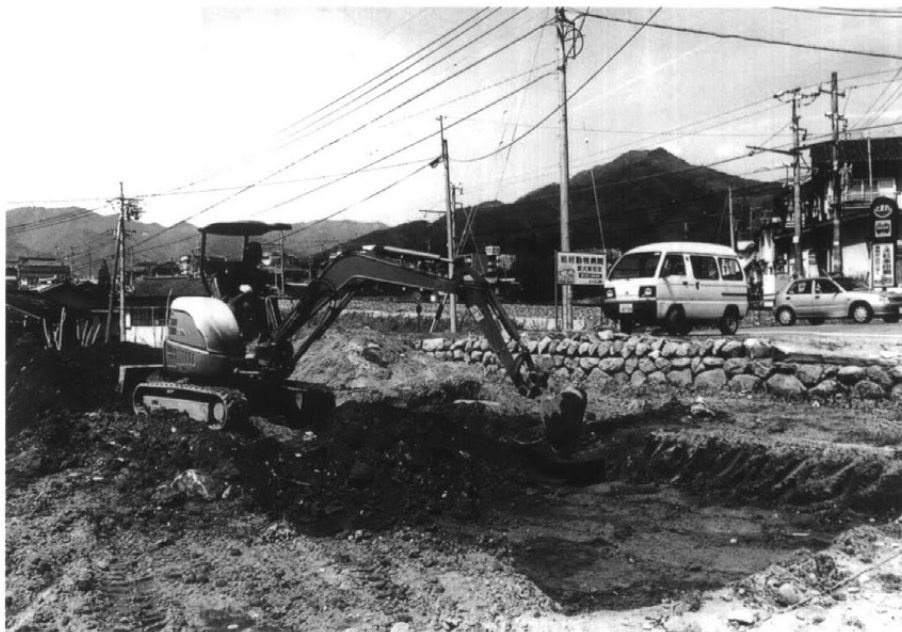
重機作業風景
