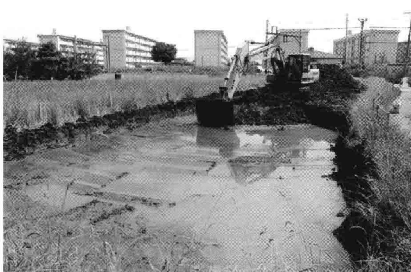
調査着手・表土除去
