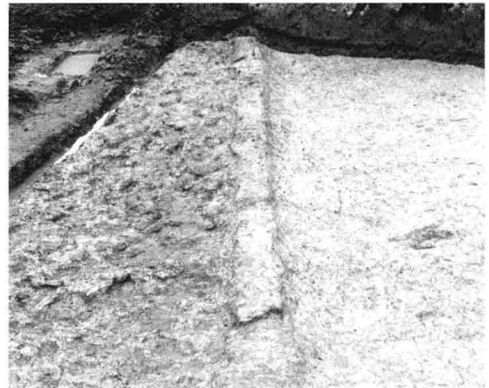
同上(粘土塊を除去した状態)
