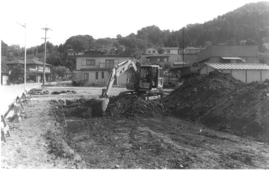
重機作業風景
