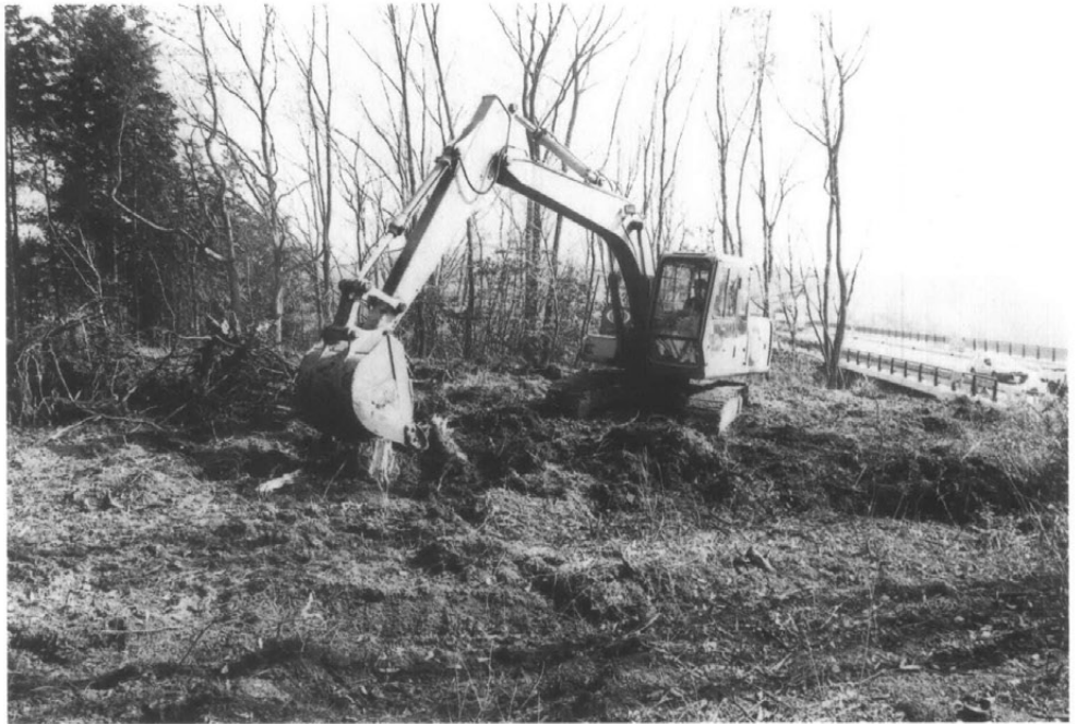
重機作業風景
