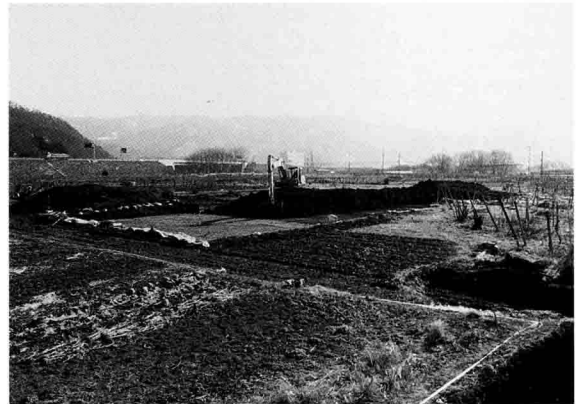
I-1 A区表土除去
