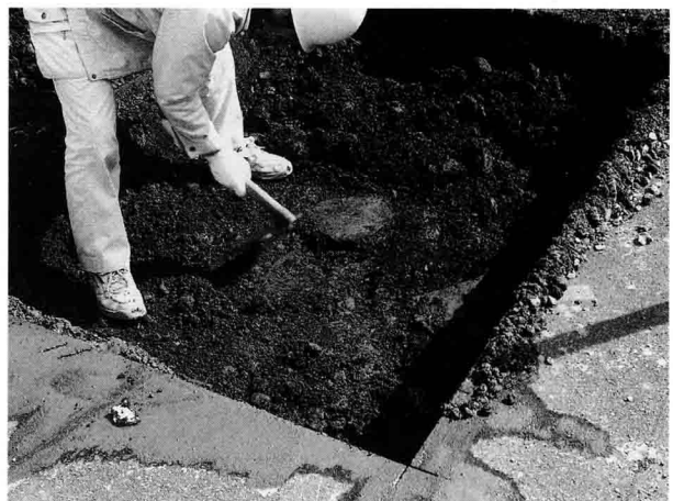
No②トレンチ（B7区）の焼土層検出
