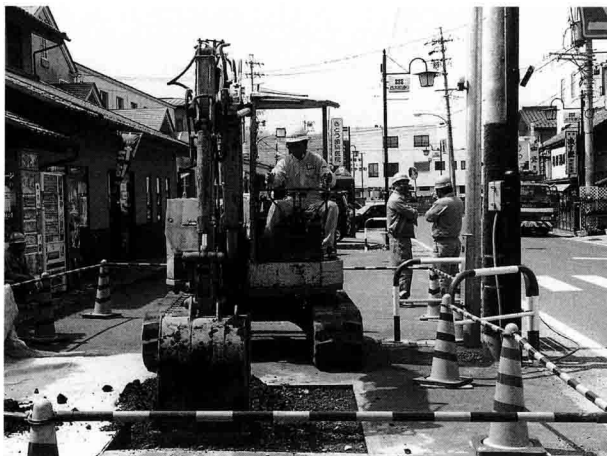
No①トレンチ（D4区）の重機掘削
