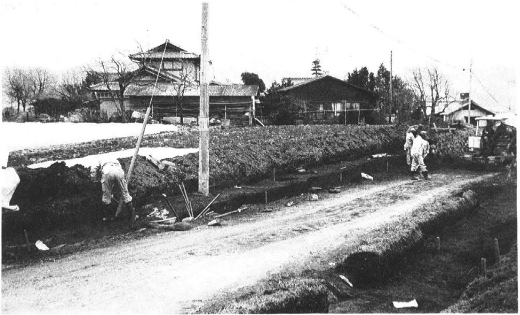
矢崎地籍重機による石垣除去作業
