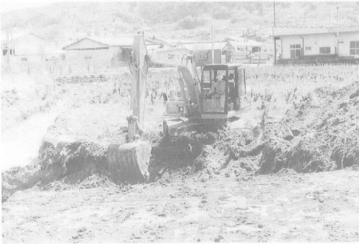
重機による 表土剥ぎ
