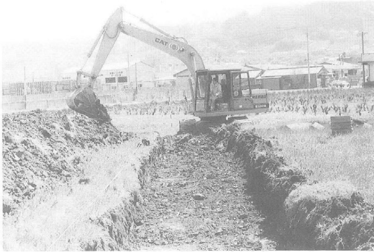
重機による トレンチ調査
