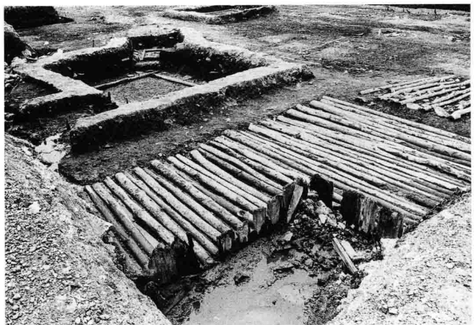
写真28 建築基礎(A2区①-8)
