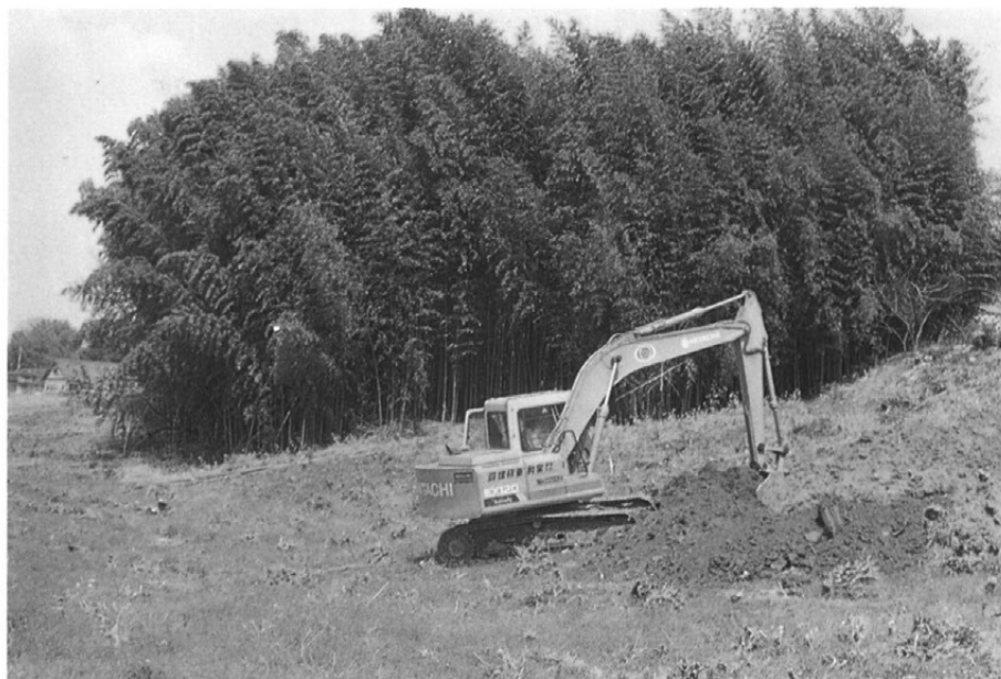
委託重機作業スナップ (b～eトレンチ)
