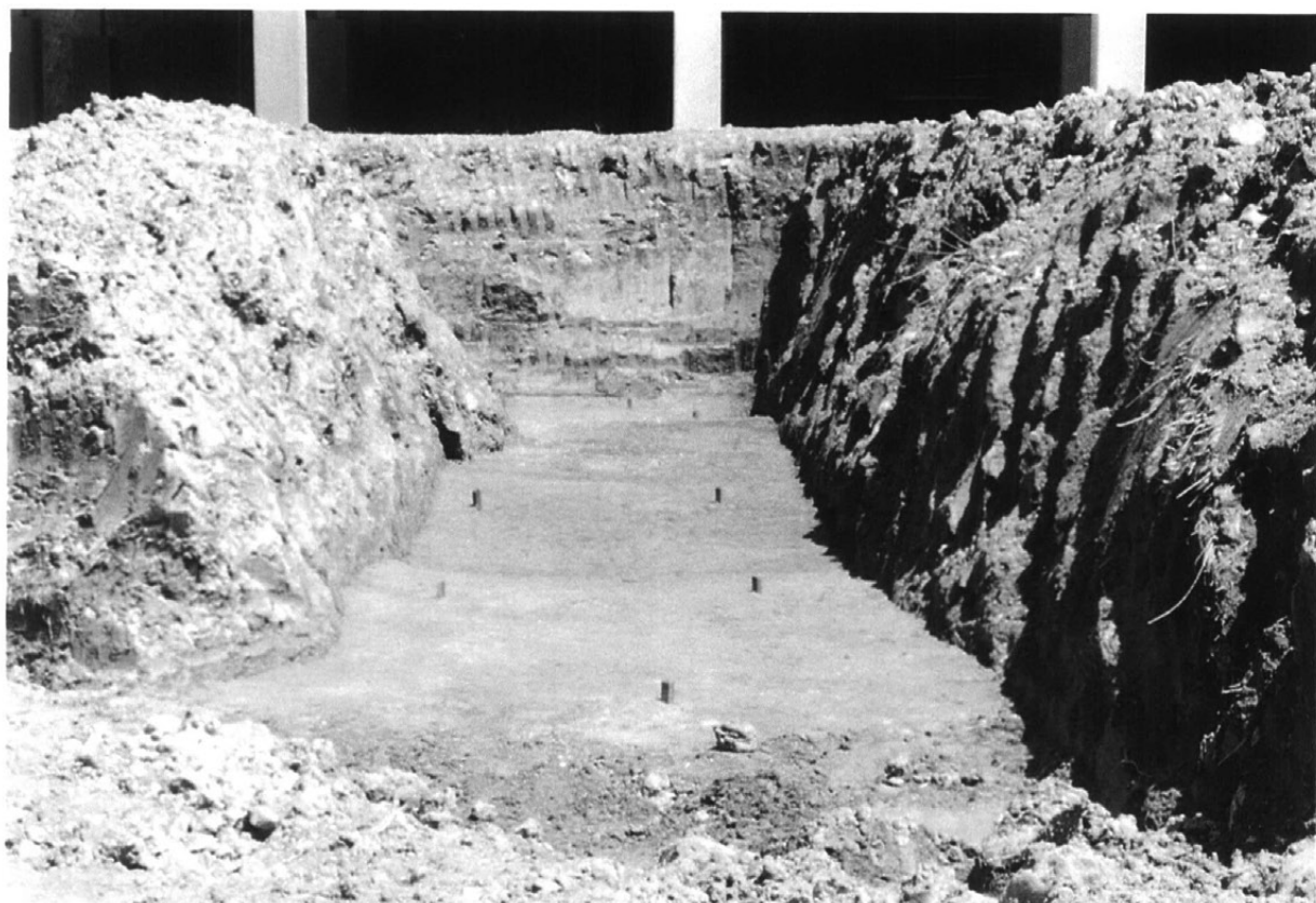
THA f トレンチ全景
