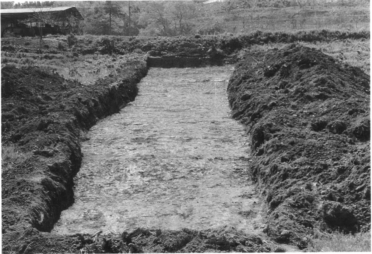
THA d トレンチ全景
