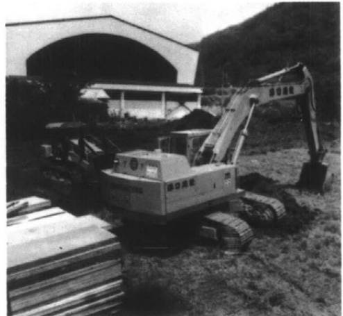
ブルドーザとユンボによる表土取り
