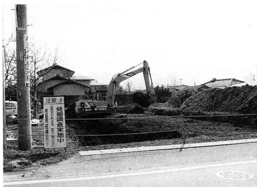
写真1 A区重機表土剥ぎ作業
