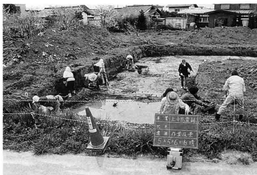
写真13 検出作業開始
