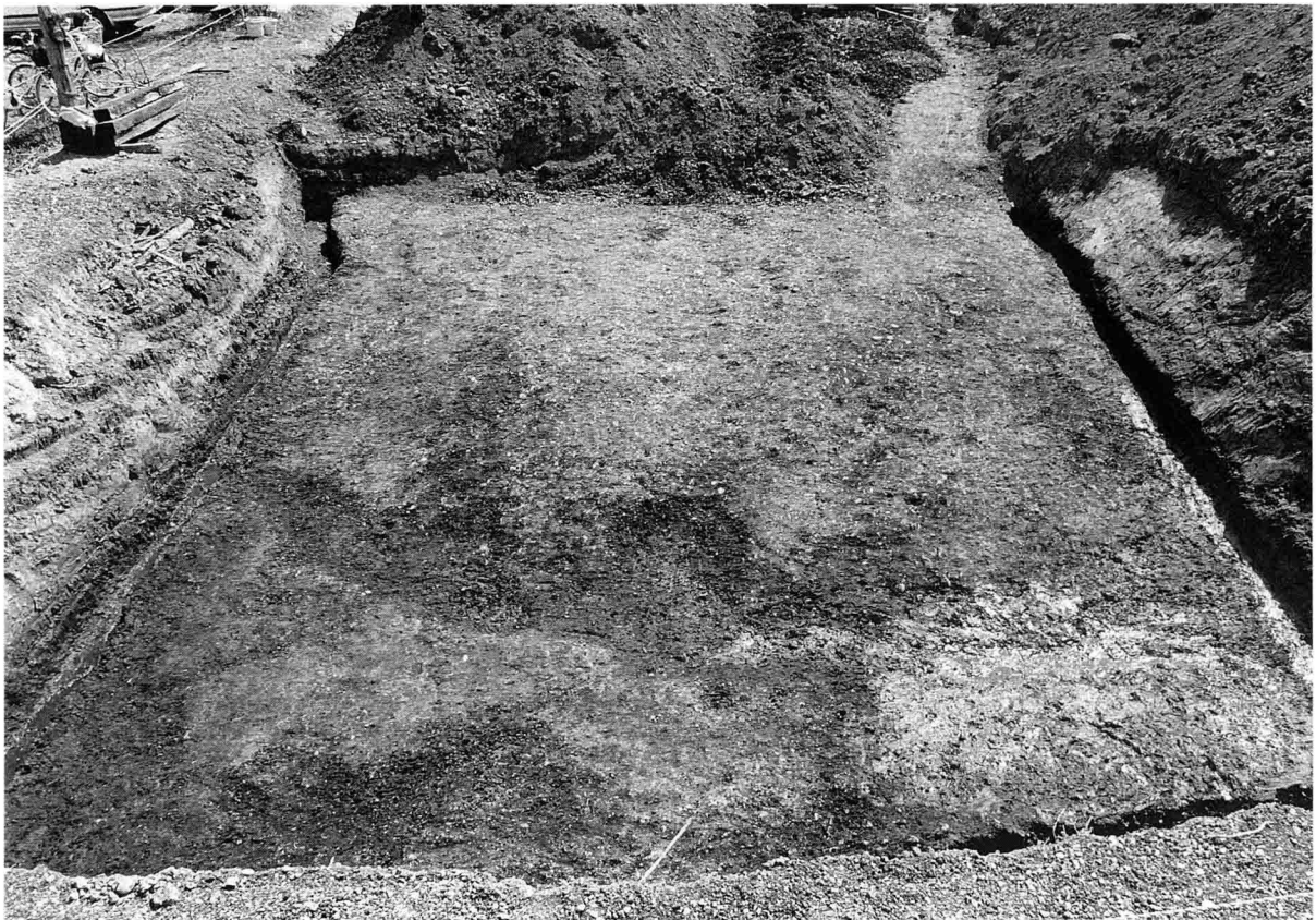
写真11 A区全景（西から）
