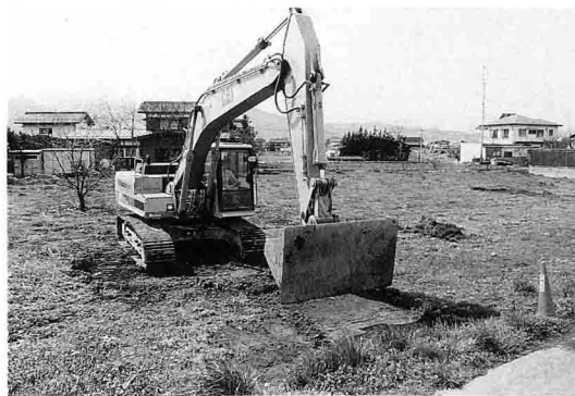
写真12 重機による表土剥ぎ
