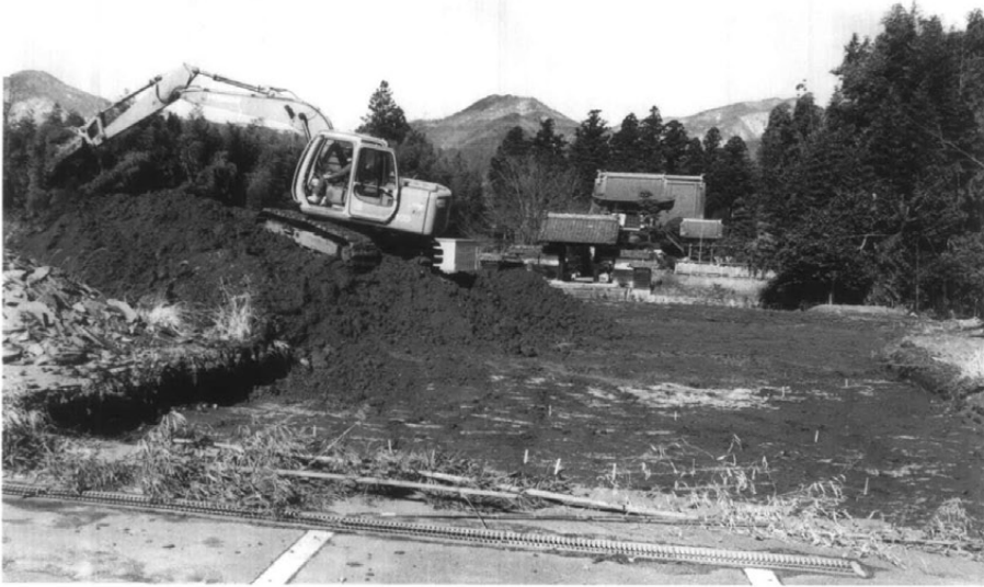
重機作業風景
